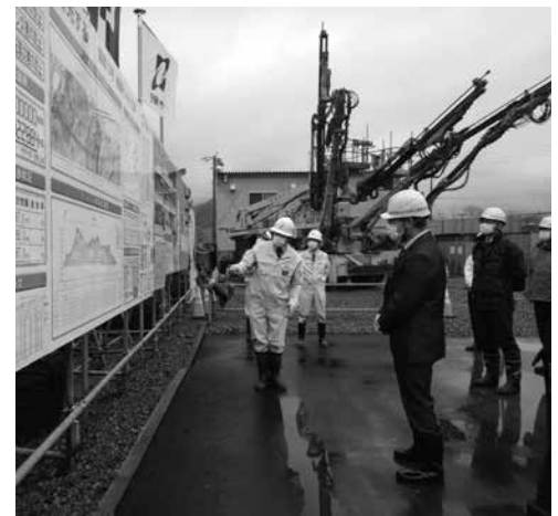
▲横堀道路の工事現場を視察
