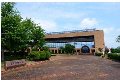
< 大規模改修を予定している湯沢文化会館 >
