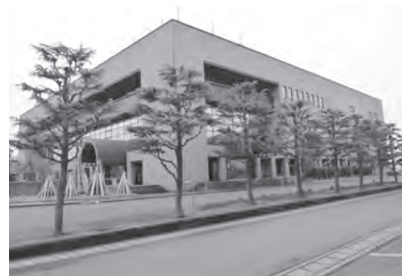
改修が予定されている湯沢文化会館
