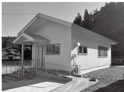
自治会館の建設(八幡林自治会)
