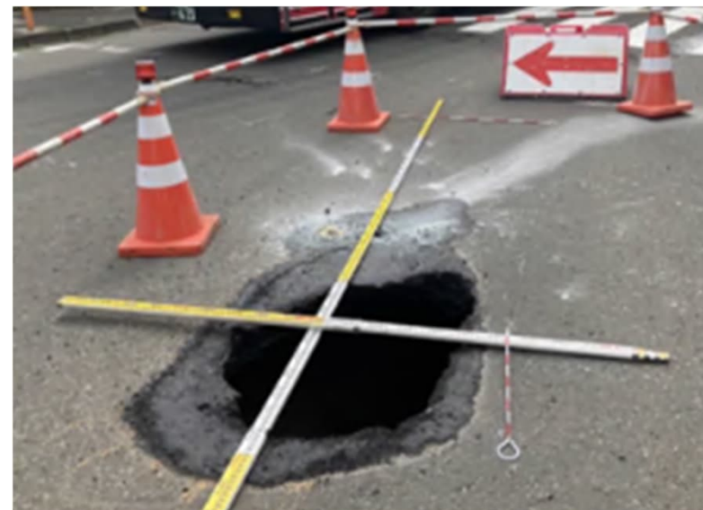
《参考》道路陥没写真
