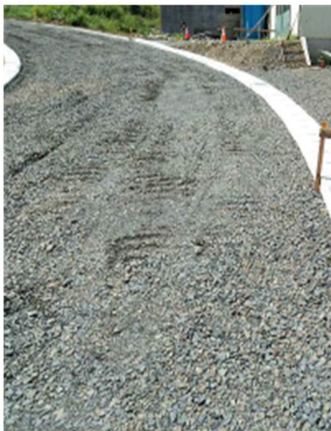
湯番所前（工事完了後）
