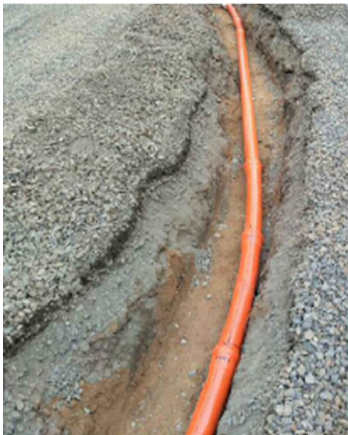
湯番所前（工事中）
