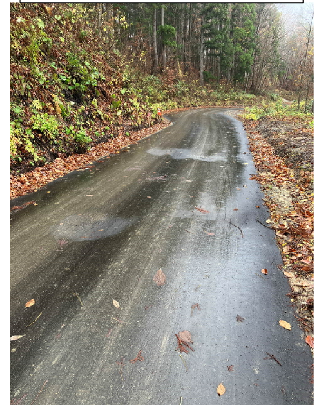
林道アスファルト舗装
