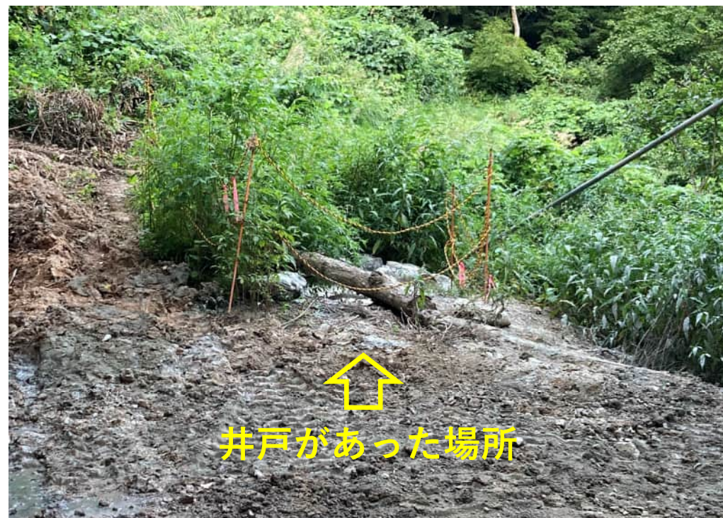
工事完了直後(2023/8/29)
